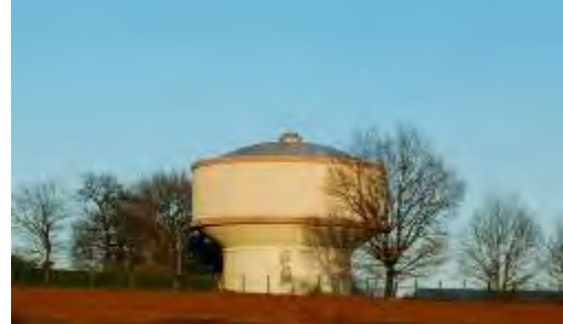
Réservoir « haut service » de la Boissonade
