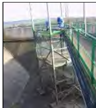
Prise d'eau du Sarret
