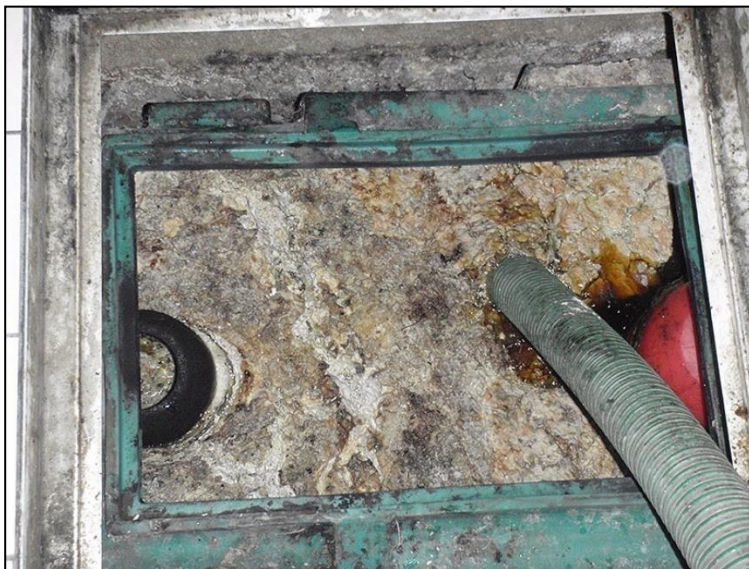
Opération de vidange d'un bac à graisses chez un restaurateur
